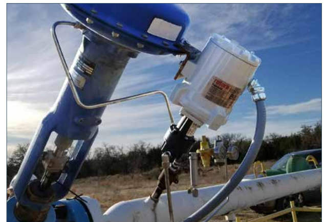
PAX1 天然ガス用コントロール弁の制御信号用
