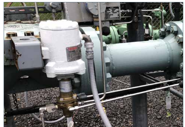
PAX1 天然ガス供給ステーションの圧力、流量制御用
